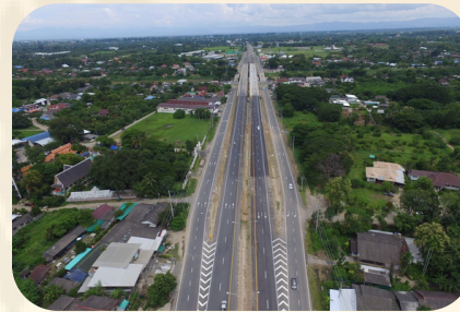
งานก่อสร้างทางหลวงหมายเลข 121 สายเลี่ยงเมืองเชียงใหม่รอบนอก ตอน 1 (เหมืองกุง-ต้นเปา) สัญญาเลขที่ สท.1/27/2558 ลงวันที่ 28 ก.ค.2558
