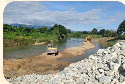
งานก่อสร้างเขื่อนป้องกันตลิ่งริมแม่น้ำวัง บ.แม่สลิค หมู่ 1,2 ต.แม่สลิค อ.บ้านตาก สัญญาเลขที่ T334/2561 ลงวันที่ 10 ส.ค.2561
