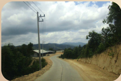
งานก่อสร้างถนนสายทางเข้าสู่ศูนย์พัฒนาโครงการหลวงเลอตอ อ.แม่ระมาด จ.ตาก,อ.อมก๋อย จ.เชียงใหม่ สัญญาเลขที่ 103/2561 ลงวันที่ 18 เม.ย.2561
