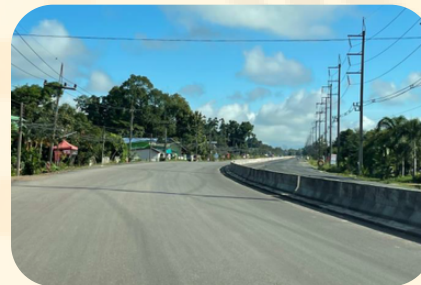
งานก่อสร้างทางหลวงหมายเลข 1021 สาย อ.ดอยคำใต้-อ.เทิง ตอน อ.เชียงคำ-อ.เทิง ตอน 2 สัญญาเลขที่ สท.1/45/2563 ลงวันที่ 30 ก.ย.2561
