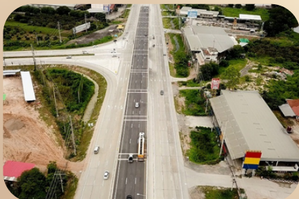
งานก่อสร้างทางหลวงหมายเลข 11 สายสามแยกดอยติ-เชียงใหม่ สัญญาเลขที่ สท.1/14/2559 ลงวันที่ 30 พ.ค.2559
