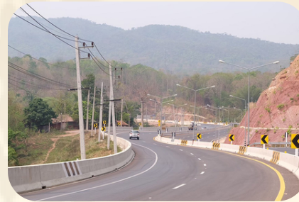
งานก่อสร้างทางหลวงหมายเลข 1021 สาย อ.ดอกคำใต้-อ.เทิง ตอน อ.เชียงคำ-อ.เทิง ตอน 1 สัญญาเลขที่ สท.1/27/2563 ลงวันที่ 11 ก.ย.2563
