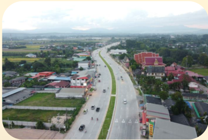
งานจ้างเหมาทำการก่อสร้างทางหลวงหมายเลข 1001 สายเชียงใหม่-บ.โป่ง สัญญาเลขที่ สท.1/3/2563 ลงวันที่ 2 ก.ค.2563
