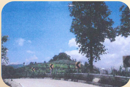
งานก่อสร้างถนนสายบ้านห้วยส้มป่อย-บ้านขุนแตะ ตำบลดอยแก้ว อำเภอจอมทอง จังหวัดเชียงใหม่ สัญญาเลขที่ 125/2560 ลงวันที่ 9 ก.พ.2560
